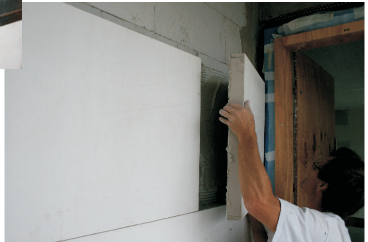
Montage der QASA-B1-Elemente im Klebebett
