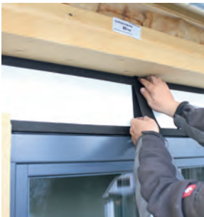
Raffstore/Rollladenkastendämmung
