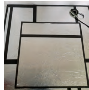
Flächenverlegung unkaschierte Paneele
