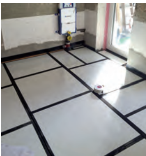
Fußbodeninnendämmung
